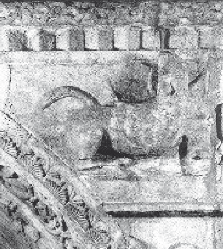
Fig. 10. Detalle de la portada (fig. 5. sit. 14). Noviembre de 1964 (después de la consolidación y limpieza). Negativo: Archivos del I.C.C.R. Madrid). Una vez consolidada la piedra, una ligera limpieza superficial ha eliminado el peligro potencial de las sales acumuladas en la superficie y ha hecho resurgir detalles perdidos.
