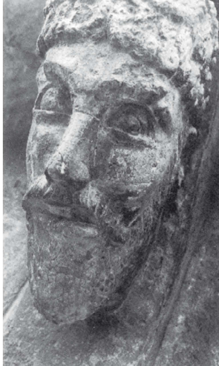
San Martín de Fromista. Detalle de un canecillo del ábside. Se aprecian los injertos antiguos de trozos de piedra en la nariz y en el pómulos izquierdo, así como el tratamiento de superficie, de color ocre, que ocultaba posiblemente los bordes de los injertos.
