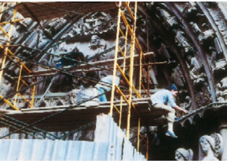
Fig. 16. Catedral de Burgos. Portada de la Coronería. Grupo de jóvenes universitarios limpiando manualmente la fachada, bajo nuestra dirección, en julio de 1979. La limpieza tiene como fin conservar y hacer legible el objeto, pero es una operación muy delicada porque es irreversible. Si bien el principio en que se basa es sencillo, su aplicación a los monumentos debe hacerse con operarios que comprendan la naturaleza de los mensajes potenciales, evitando la utilización de los sistemas industriales normalmente en uso por las empresas de limpieza. En multitud de monumentos de primera magnitud que han sido limpiados en los últimos tiempos, se ha podido demostrar el uso de sistemas totalmente desaconsejables, tales como el chorro de arena, agua a presión, productos químicos ácidos y alcalinos, etc., llegándose incluso a detectar el empleo de sosa cáustica y ácido clorhídrico.
