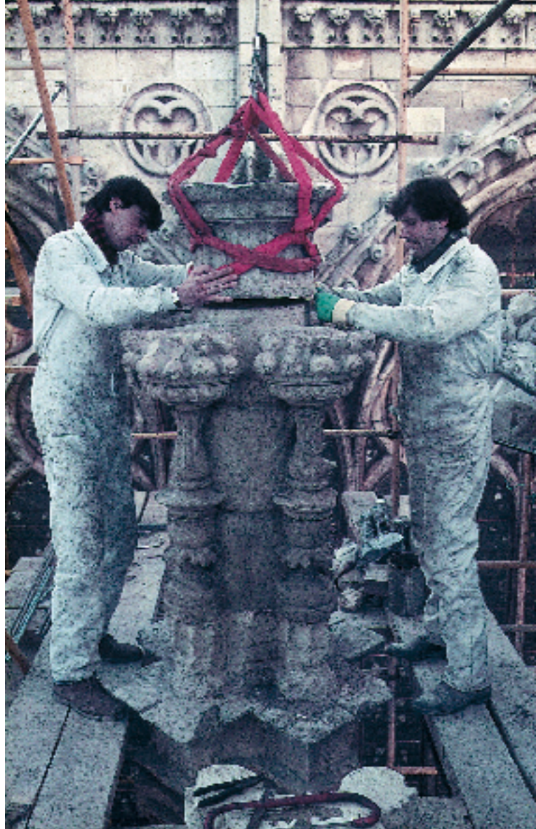
Durante la reinstalación de los pináculos desmontados en su lugar de origen.
