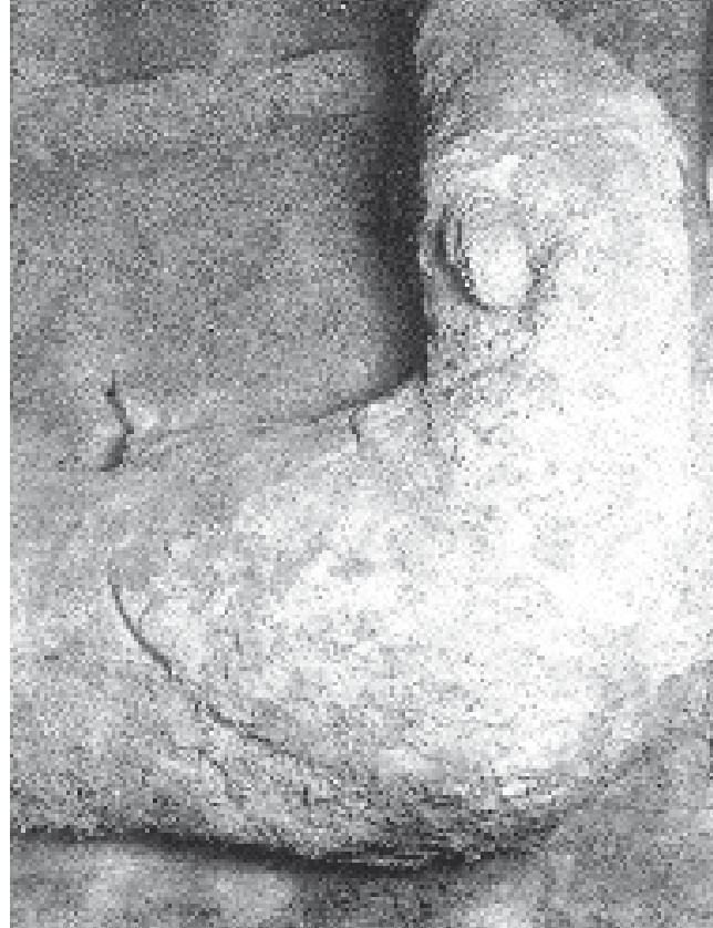
Fig. 9. Detalle de la portada (Fig. 5. sit. 14). Noviembre de 1964 (antes de la consolidación). Negativo: Archivos del I.C.C.R. Madrid. Las eflorescencias blancas recubren totalmente la piedra; los depósitos de mugre deforman los relieves; la alteración ha progresado considerablemente en los últimos años (ver fig. 8)
