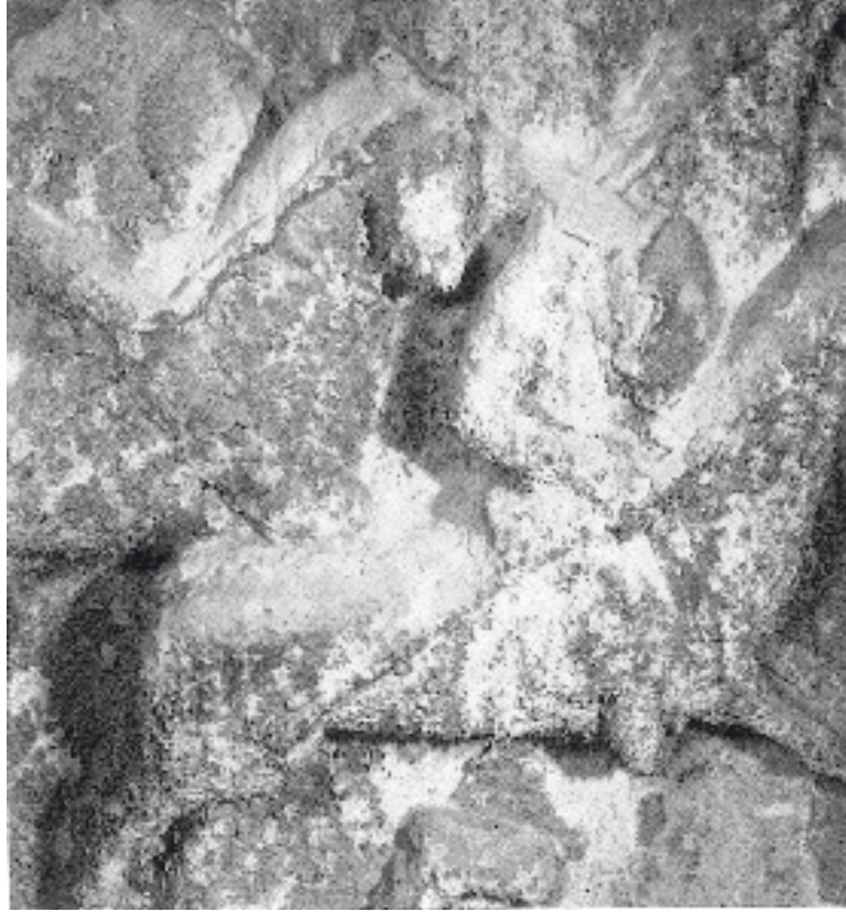
Fig. 18 Detalle de la portada (Fig. 5. Sit. 34). Noviembre de 1964 (antes de la consolidación y limpieza). Negativo: Archivos del I.C.C.R. Madrid. La condición de “Respeto a la apariencia del ojeito” debe precisarse con el concepto de Patina, que es una alteración de la superficie del material, caracterizada por una penetración a veces profunda, y que no se puede eliminar sin herir, sea levemente, la materia original. No debe confundirse con la suciedad que, generalmente, forma un depósito de “mugre” y que puede ser eliminada en el tratamiento.
