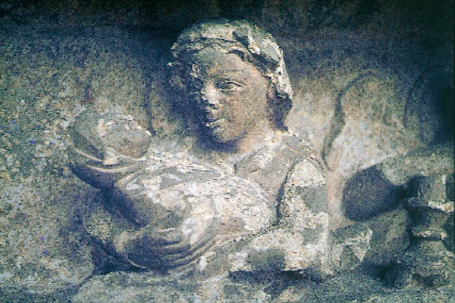
Detalle del tímpano mostrando el «picado» de la patina por la acción del agua que les salpica desde las gárgolas.
