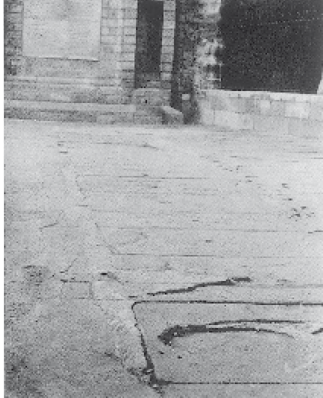
Fig.14 y 15. Detalles de la acequia subterránez que pasa a unos diez metros de la portada; sus paredes están en muy mal estado de conservación y, durante casi todo el año, sobre las losas del patio hay gran cantidad del agua que rebosa. Negativos: Archivos del I.C..C.R. Madrid.
