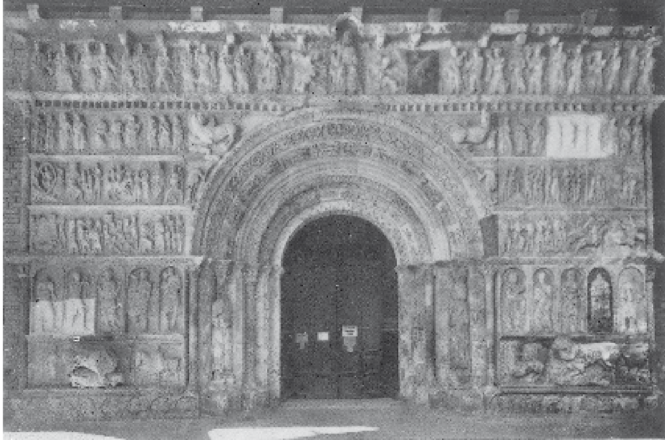
Vista general de la portada. Noviembre de 1964 (antes de la consolidación)
