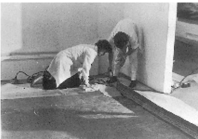
3. Durante el desmontaje en Nueva York. Especialistas del Departamento de Restauración del MOMA proceden a planchar los bordes con aire caliente y muñequillas de tela.
