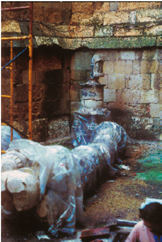
Catedral de León. Pináculos del costado norte antes y después de la intervención de 1983. La oxidación de los vástagos de hierro y de las grapas que unen casi todos los elementos de piedra, producen el estallamiento de ésta. Frente a quienes proponen sustituir estos elementos por otros nuevos, hemos intervenido reparándolos cuidadosamente, insertando varillas de acero inoxidable en lugar del hierro oxidado y pegando los fragmentos con resinas epoxidicas. Con igual criterio se ha actuado en la aguja de la Torre del Reloj y en los demás ornamentos de piedra de toda ella, lo que constituye ya un documento elocuente.
