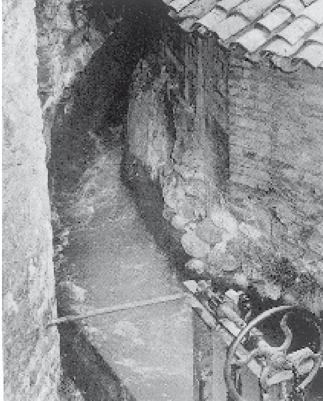
Fig.14 y 15. Detalles de la acequia subterránez que pasa a unos diez metros de la portada; sus paredes están en muy mal estado de conservación y, durante casi todo el año, sobre las losas del patio hay gran cantidad del agua que rebosa. Negativos: Archivos del I.C..C.R. Madrid.
