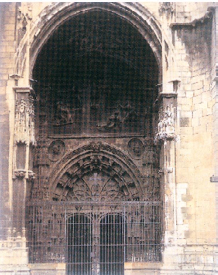
CATEDRAL DE OVIEDO. PORTICO OCCIDENTAL Fig. 9. Sobre toda la superficie esculpida se conserva en muy buen estado un recubrimiento de superficie con estuco de yeso y arena de cuarzo (10: 1) teñido con algo de ocre y aglutinado con una sustancia de naturaleza óleo-proteica.
