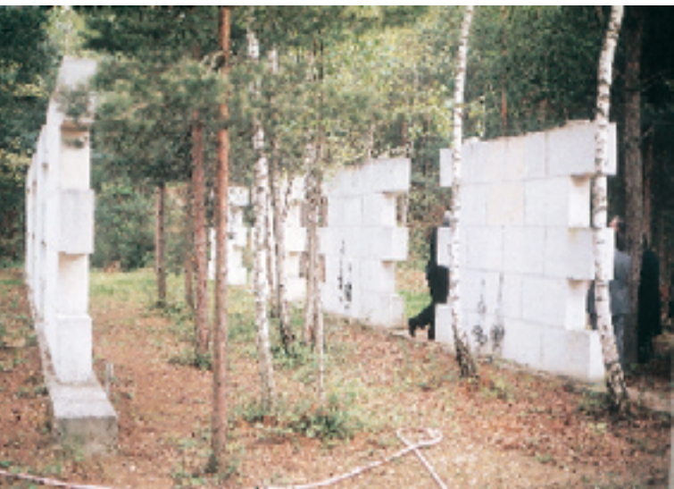
Fig. 6. Institut Technique de Batiment et Travaux Publics, París. Muros experimentales para contrastar la eficacia de soluciones. Las sondas instaladas permiten el estudio continuo de la humedad, permitiendo verificar el contenido y la distribución del agua antes y después de la aplicación de los distintos sistemas “y productos existentes en el ‘ mercado, lo que ha permitido decantar razonablemente la información existente.
