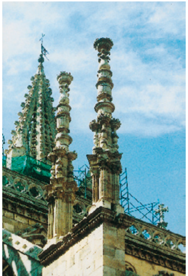
Catedral de León. Pináculos del costado norte antes y después de la intervención de 1983. La oxidación de los vástagos de hierro y de las grapas que unen casi todos los elementos de piedra, producen el estallamiento de ésta. Frente a quienes proponen sustituir estos elementos por otros nuevos, hemos intervenido reparándolos cuidadosamente, insertando varillas de acero inoxidable en lugar del hierro oxidado y pegando los fragmentos con resinas epoxidicas. Con igual criterio se ha actuado en la aguja de la Torre del Reloj y en los demás ornamentos de piedra de toda ella, lo que constituye ya un documento elocuente.
