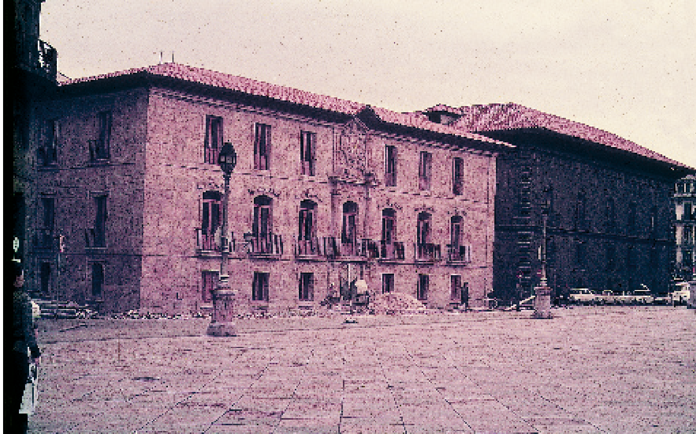
Oviedo durante la limpieza de fachadas.
