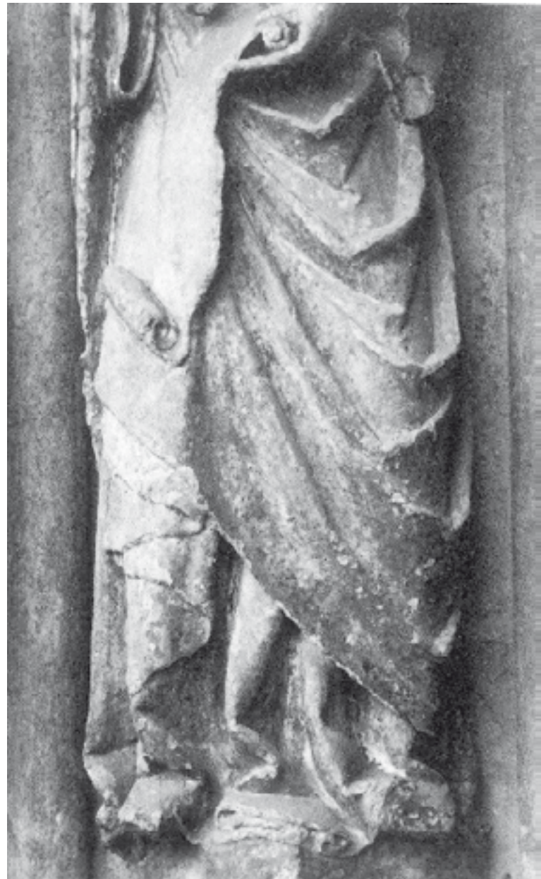
Restos de policromía en el Pórtico Occidental de la Catedral de León, de diferentes colores. Es el resultado de las intervenciones con cepillos de acero para sanear la piedra.
