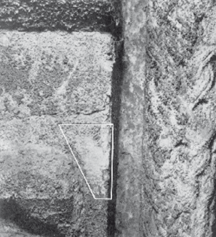
Fig.17. Detalle de la portada (sit. 15) Noviembre de 1964 (antes de la consolidación). Negativo: Archivos del I.C.C.R. Madrid. El análisis químico de esta muestra superficial revela la presencia de un 33.7 por 100 de sales blancas compuestas esencialmente por Cloruros, Sulfatos y Nitratos alcalinos y alcalinotérreos.
