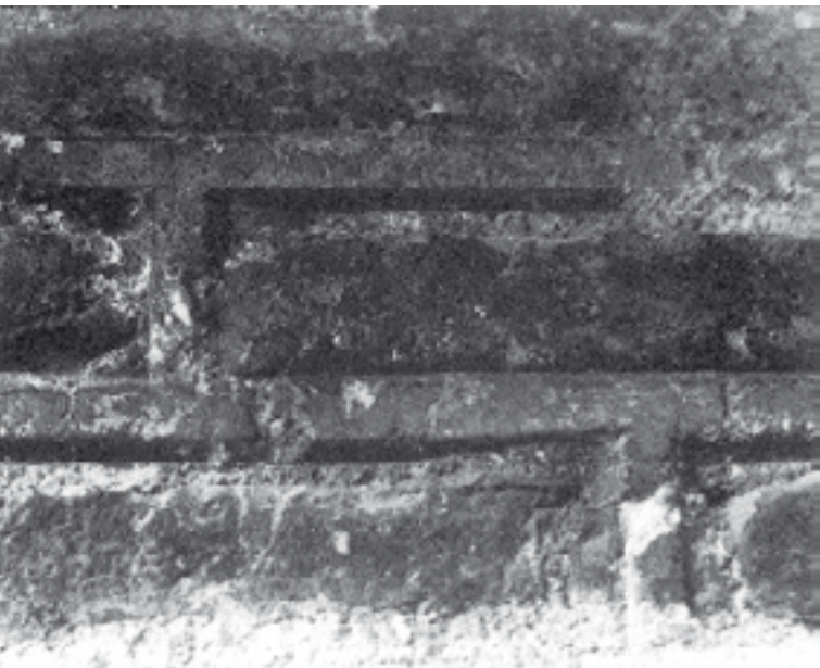
San Pedro Mártir (Toledo). Detalle de la fábrica de ladrillo con encintados de mortero de cal y arena. Se pinta en rojo (alrnagra con temple de huevo) el casetón de ladrillo y los taludes internos del encintado. El frente del encintado se pinta con ocre y temple de huevo. Este tipo de encintados abunda en Toledo, Alcalá de Henares y otras localidades de la Diócesis, en edificios religiosos y civiles del siglo XVII, y poco tienen en común con las toscas fábricas de ladrillo impuestas por los restauradores en estas ciudades.
