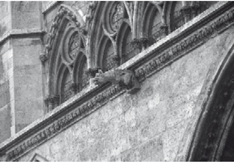
Detalle de una de las dos gárgolas que dan salida a las pluviales.
