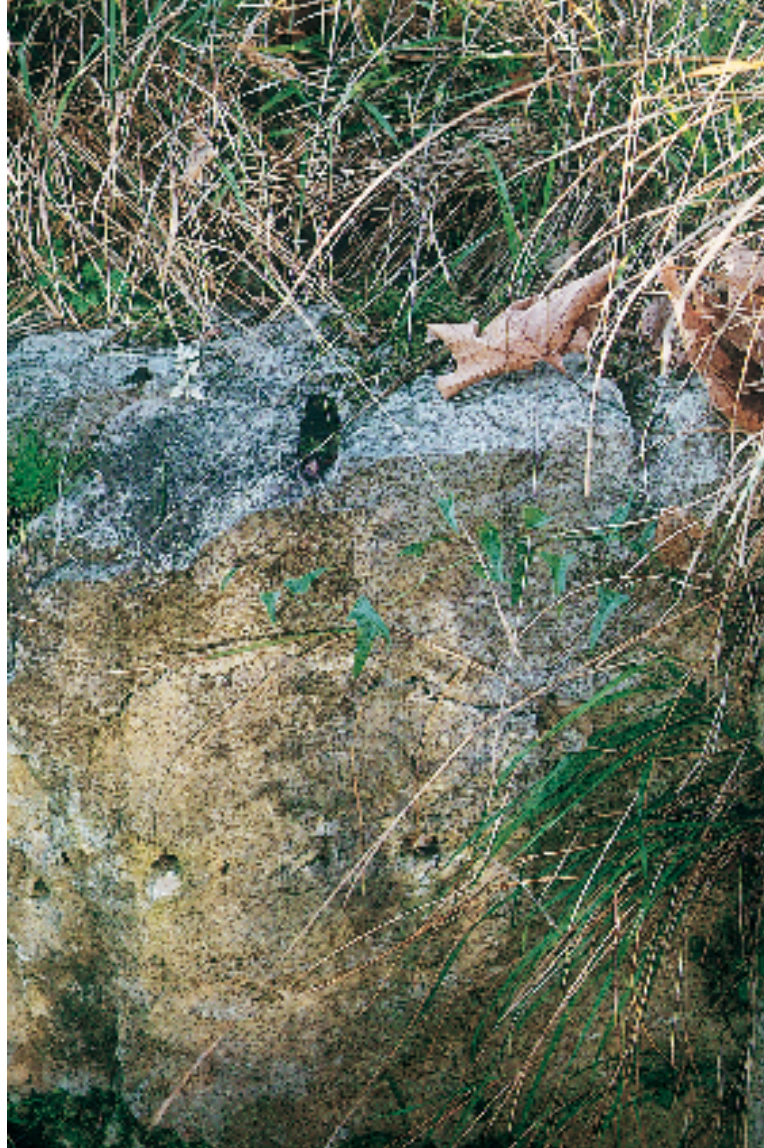
Detalle de los taladros para los barrenos de pólvora empleados en la cantera.
