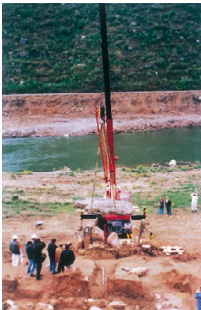
El Dolmén dels tres Pílers, durante las obras para su transposición.
