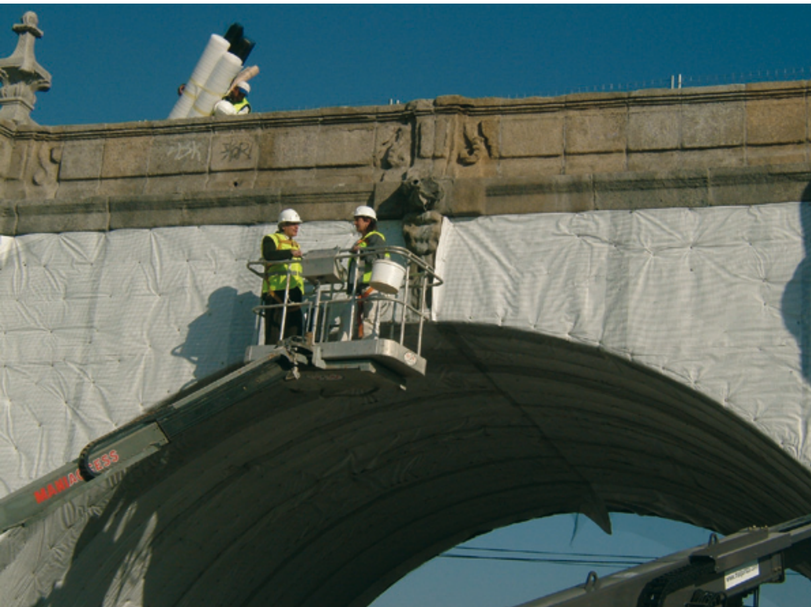
José María Cabrera revisando la protección aplicada a las paredes del Puente de Toledo con motivo de las obras en la M-30 de Madrid.
