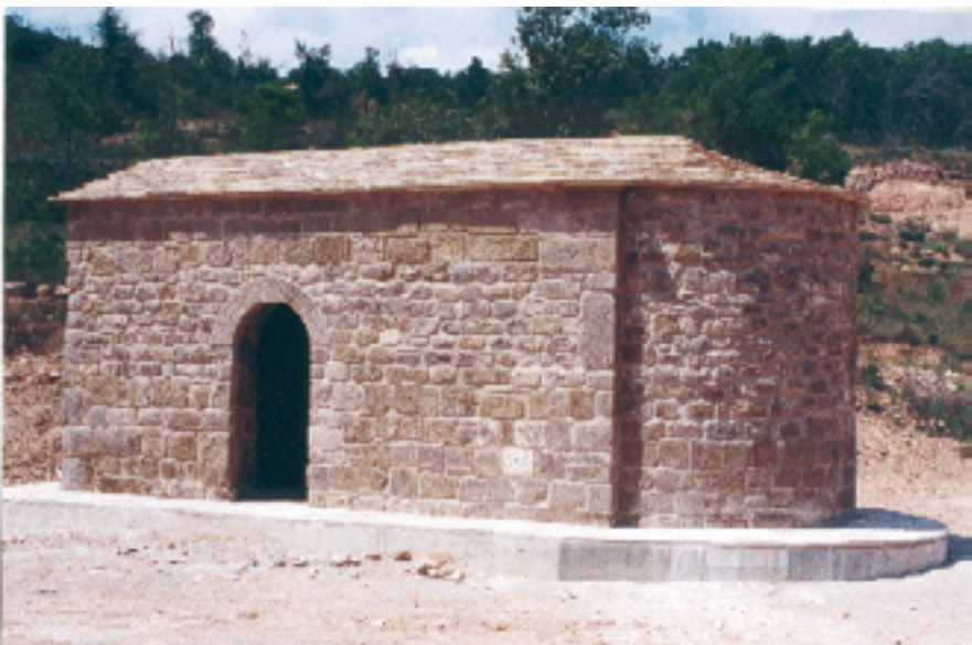
Después de la Restauración de Sant Girves de la Torre.
