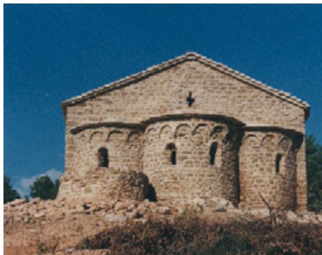
Sant Marti de la Clua, estado restaurado Exterior
