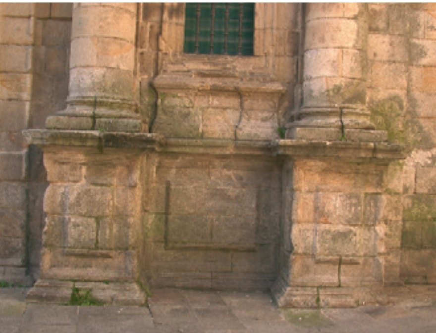
La recuperación de la geometría se consigue con la utilización de morteros petreos de reposición
