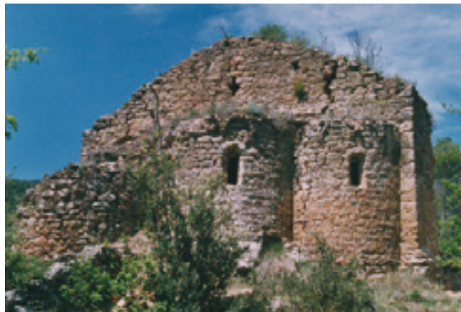
Sant Marti de la Clua, estado inicial EXTERIOR
