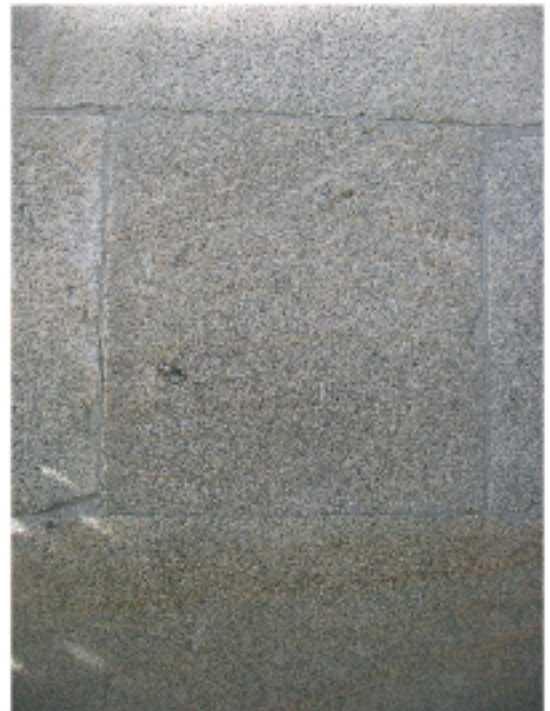
Vista parcial de los morteros en las juntas de sillares, antes y después de la restauración.
