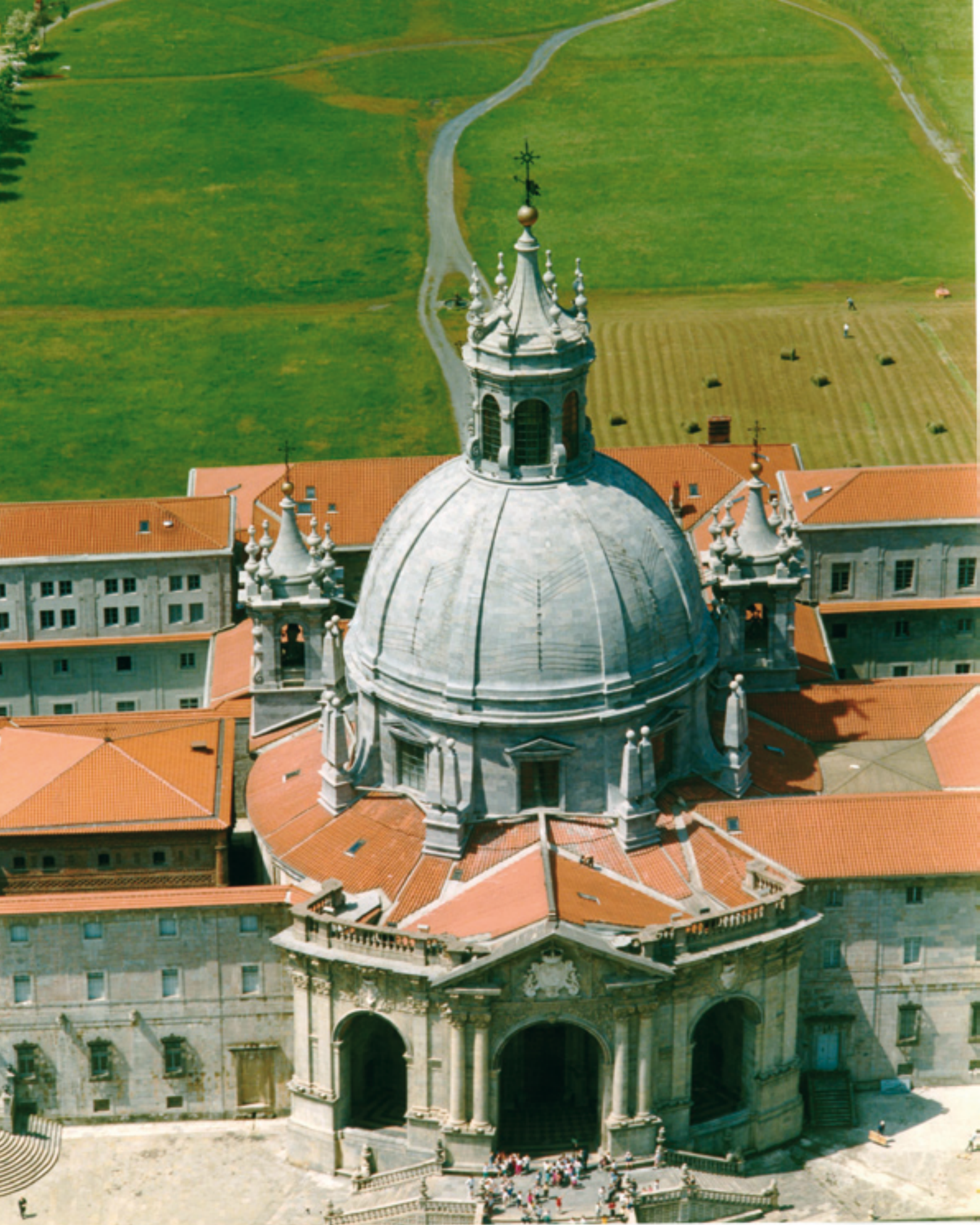
Cúpula con los refuerzos de atirantado para su consolidación.
