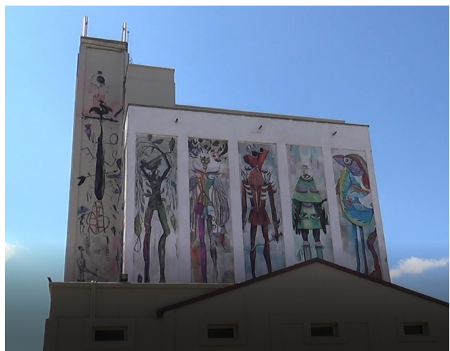
Figura 2.- Silo de Almagro. 2018
