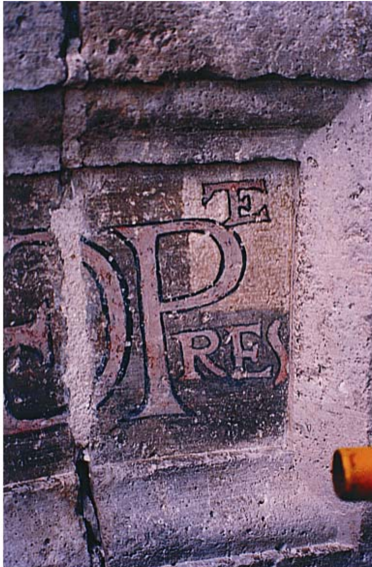
5. Cata de limpoieza con láser sobre caliza (Iglesia parroquial de Tudela de Duero. Valladolid) Obsérvese la permanencia de la pátina respecto a la sección derecha sometida a otro tipo de limpieza más agresiva.
