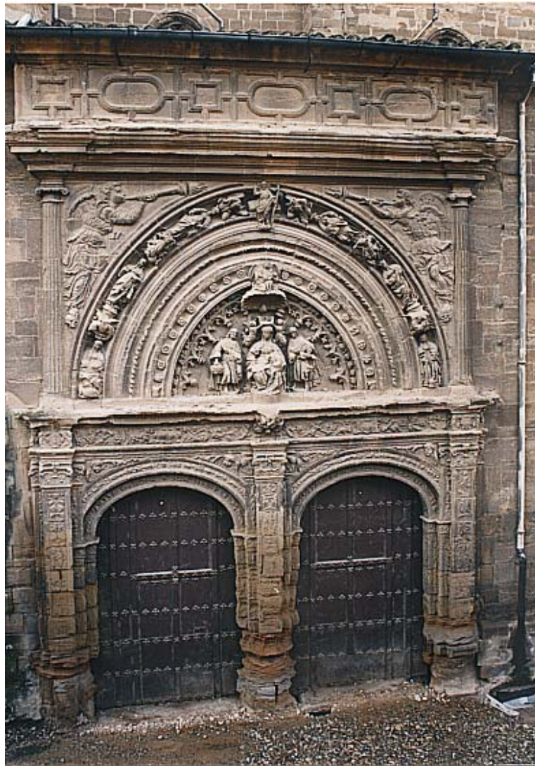
1. Aspecto de la portada antes de la intervención
