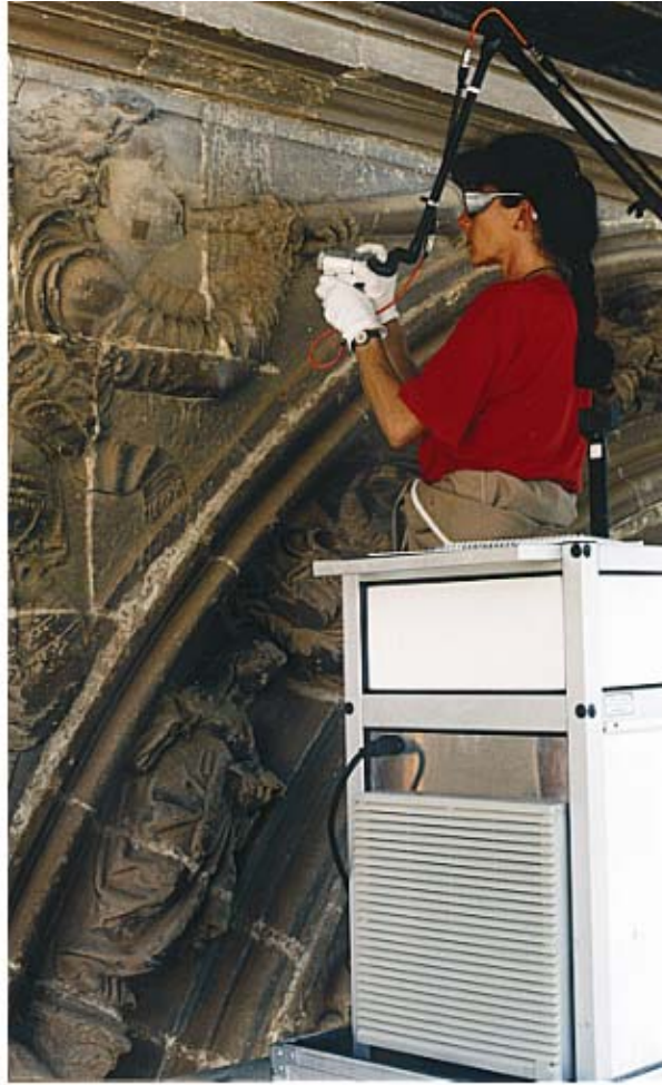
2 y 3. Proceso de limpieza mediante desincrustación fotónica
