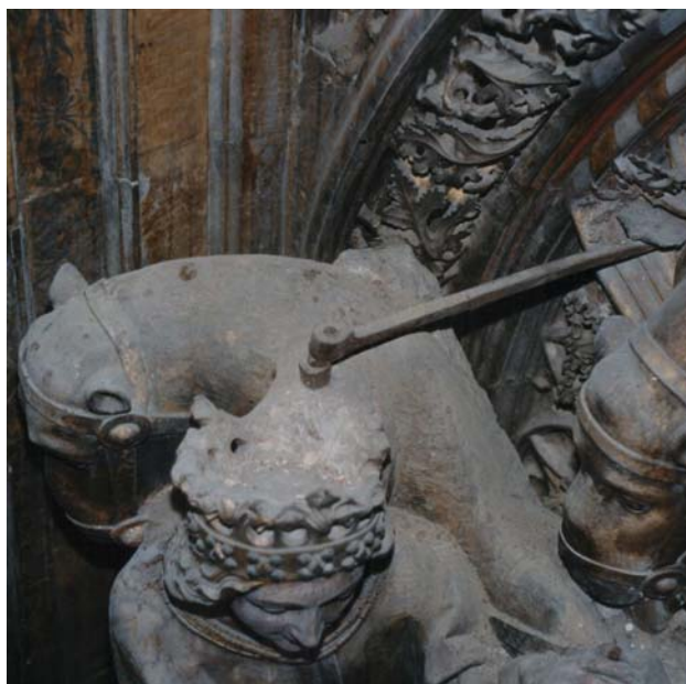
Fotografía nº 1.- Barra de hierro para asegurar una de las figuras principales hacia el muro-soporte posterior. Retablo Mayor de la Seo. Foto: Carlos Jiménez Cuenca.
