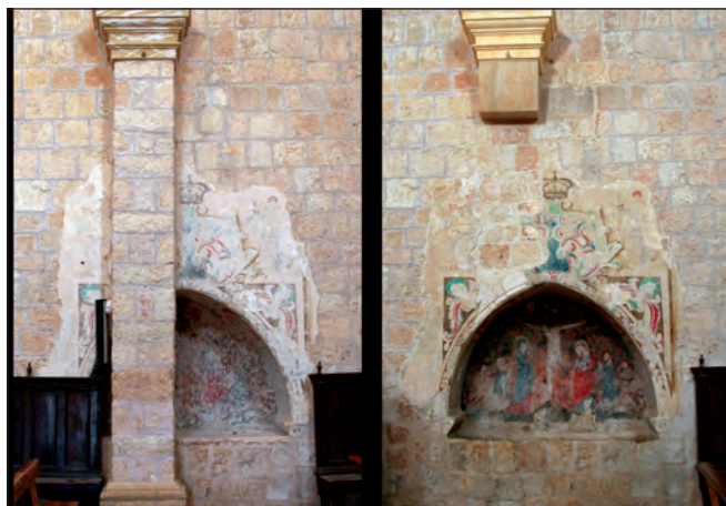
Fig. 2. Espacio intervenido (antes y después).
