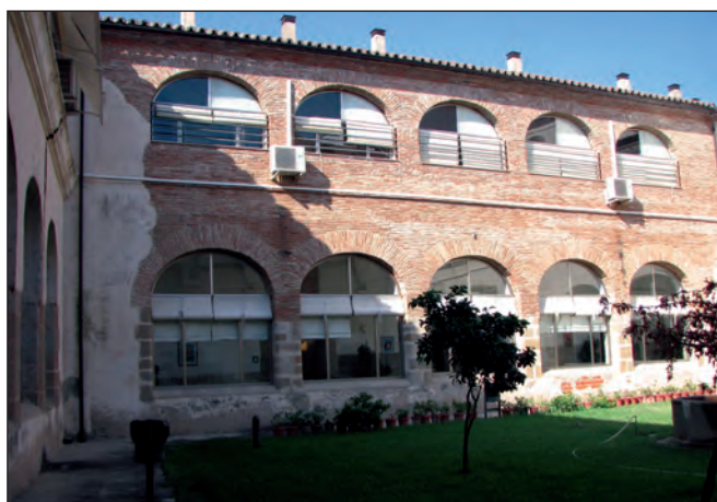
Fig. 2. Plasencia (Cáceres). San Francisco. Claustro.
