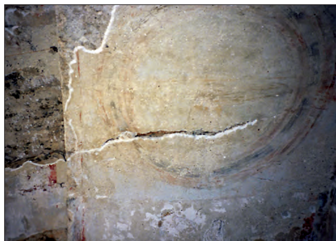
Fig. 6. Centro del arco triunfal de la iglesia de Sant Climent de Taüll. Restauración de las capas profundas de la Dextera Domini conservadas in situ .
