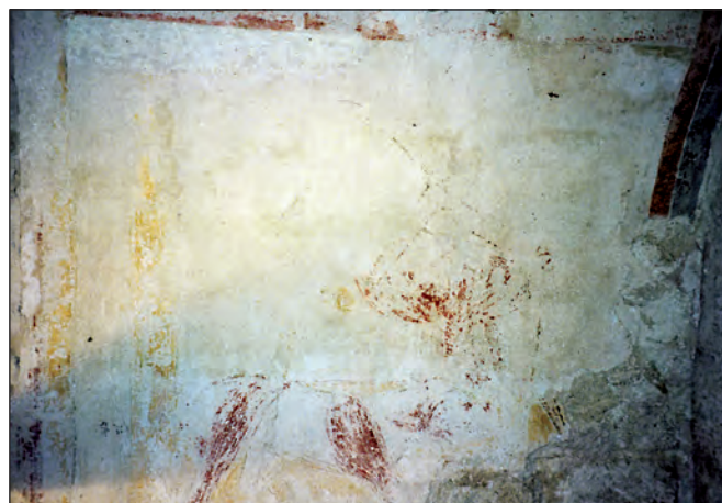
Fig. 4. Restos del arranque de la escena de Lázaro con el perro . Capas profundas conservadas en la iglesia de Sant Climent de Taüll después de la restauración.
