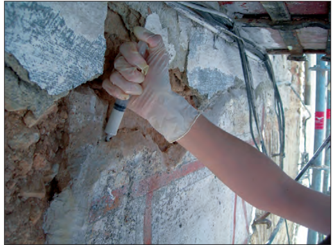
Fig. 2. Consolidación y relleno de oquedades del revoco. Aplicación de mortero de inyección.
