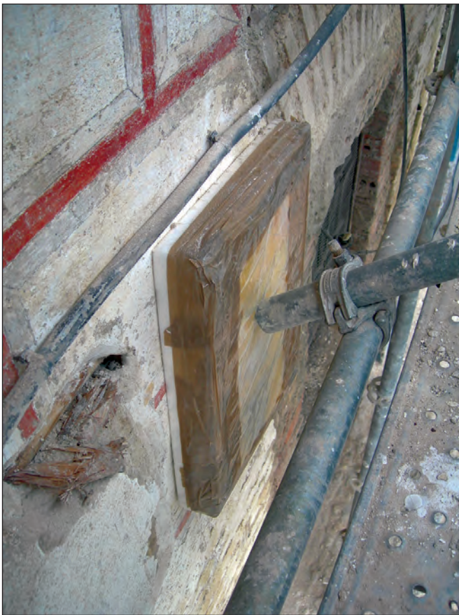
Fig. 3. Sentado del revoco desprendido mediante mortero de inyección y presión.
