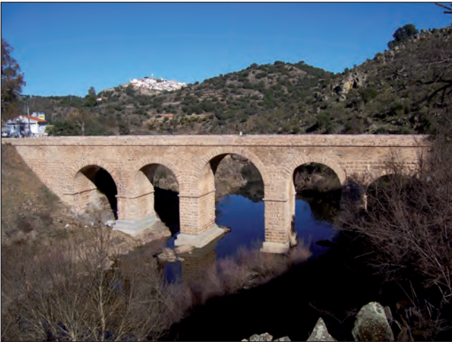
Fig. 1. Puente con las distintas pátinas y el posterior recrecido del siglo XIX.
